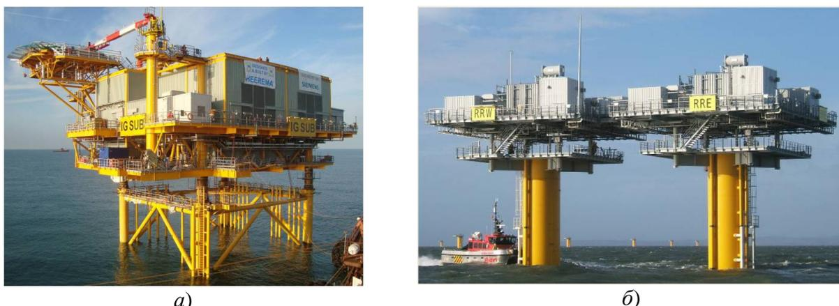
Рисунок 2.2.10 – Внешний трансформаторных подстанций на закрытых (а) и открытых (б) морских платформах
