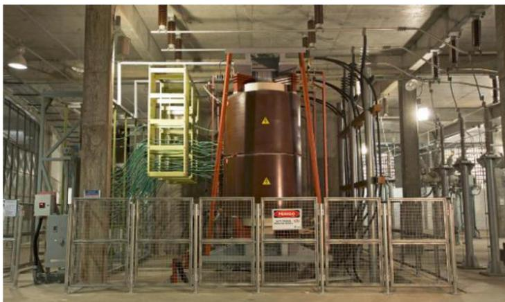
Рисунок 2.3.3 – Закрытая подстанция стадиона Fonte Nova с установленным сухим трансформатором напряжением 69 кВ мощностью 25 МВА с устройством РПН
