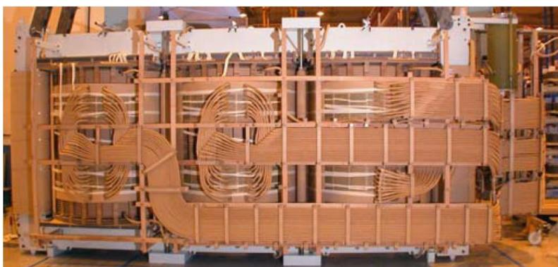
Рисунок 2.2.12 – Активная часть переменного шунтирующего реактора напряжением 420 кВ мощностью 90 – 200 Мвар
