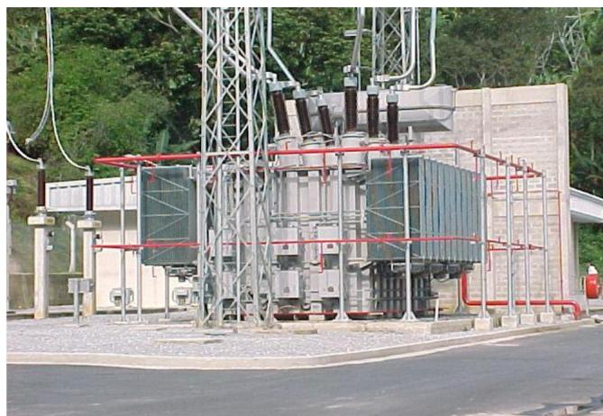
Рисунок 2.2.3 – Фазопоротный трансформатор напряжением 138 кВ проходной мощностью 400 МВА на подстанции Angra dos Reis
