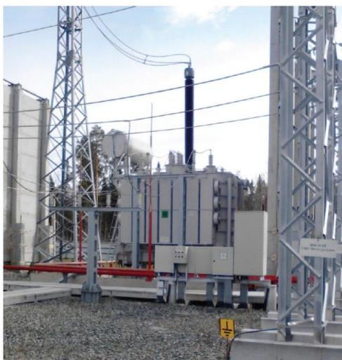
Рисунок 2.2.7 – Управляемый шунтирующий реактор напряжением 500 кВ мощностью на фазу 60 Мвар на подстанции «Нелым»
